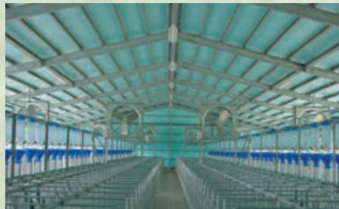
施工例 ウッドラックGR (屋根・壁)
