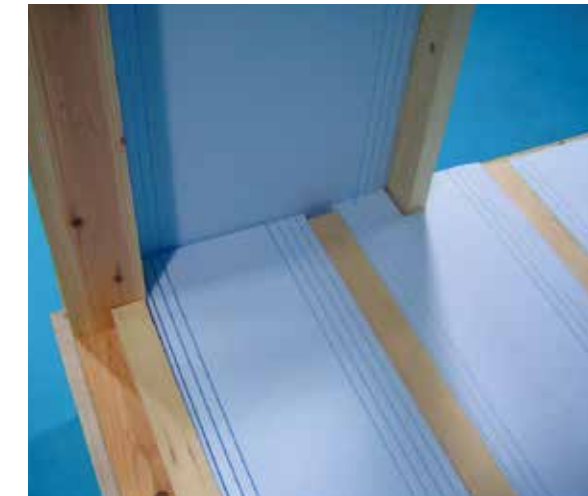
●木材との間にできる「目地開き」を防止するためのスリットです。落下しにくくなっていますが、落下防止にはWZピン™や受け木等を取り付けてください。
