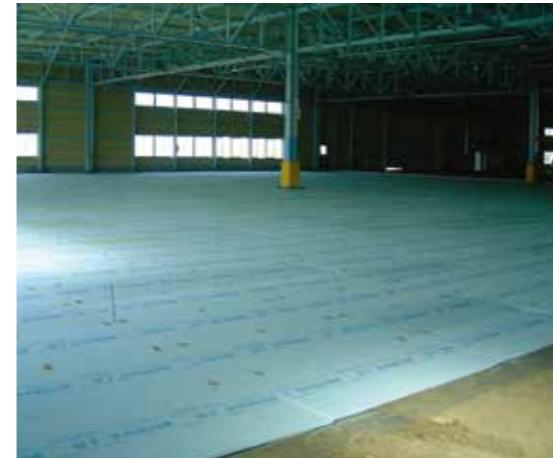
スタイロフォーム™とポリエチレンフィルムを一体化成形した土間用防湿材付断熱パネルです。断熱材と防湿シートの敷込作業が一度ですみ、工期短縮がはかれます。また、目地部分もフィルムの耳部をかさねる工法ですから、より確かな断熱・防湿効果が得られます。
