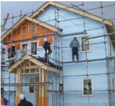
柱の外側に断熱材を張り、その上に通気胴縁を取り付け通気層を確保する工法。従来の充填断熱工法に比べ、断熱・気密性に優れ、快適な居住空間を実現します。
