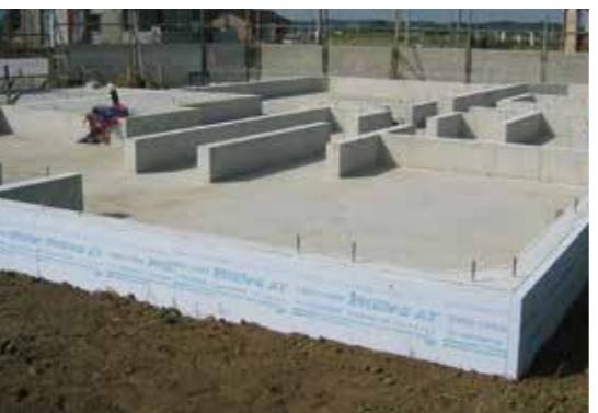
●新築の基礎外側断熱は同時打込みとしてください。基礎外側の後貼りは、断熱材裏面からのシロアリ這い上がり等が生じる可能性が高くなるので実施しないでください。
