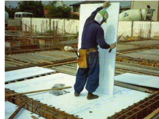
スタイロフォーム™と特殊フィルムを一体化成形した、床、ピットスラブ専用の型枠兼用断熱パネルです。従来の型枠と同様に敷込、コンクリート打設後は捨て型枠材として撤去する必要がありませんので作業工程の短縮・省力化がはかれます。
