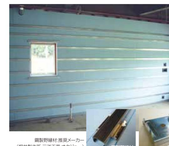
フレイムワーク™MZクリッパー工法は、専用クリップを用いてスタイロフォーム™を壁面に取り付けた後、市販の鋼製野縁材をはめ込むだけのワンタッチ施工で内装下地が完成します。優れた施工性と養生不要の工法で工期を大幅に短縮します。また、内張断熱工法ですから、従来工法に有りがちな断熱欠損部や断熱材のずり落ちもなく、きわめて高い断熱効果と結露防止効果が得られます。
