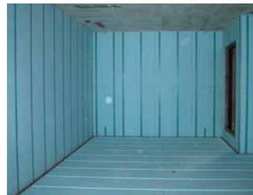
高い断熱性能を持つドレイナーパネル™を特殊接着剤を用いて地下外周壁に後貼りした後、床断熱排水パネルドースイライナー™を耐圧盤上に敷き込むだけで二重壁と二重スラブの性能を確保し、断熱性能も加味した地下湧水処理断熱システムが完成します。ドレイナーパネル™はデュポン・スタイル(株)の指定工事店が、施工マニュアルに基づいて工事を行う、安心の施工体制です。
