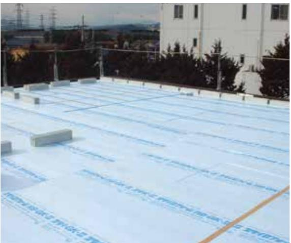
スタイロフォーム™ RB・GK-IIを防水層の上に施工することにより、外気の流入熱と太陽の輻射熱を防水層やコンクリートスラブに伝えません、そのことにより防水層やコンクリートスラブの劣化を防止します。天井局部結露の発生を防止し、夏季の夜間に起こる「ほてり」をなくします。
