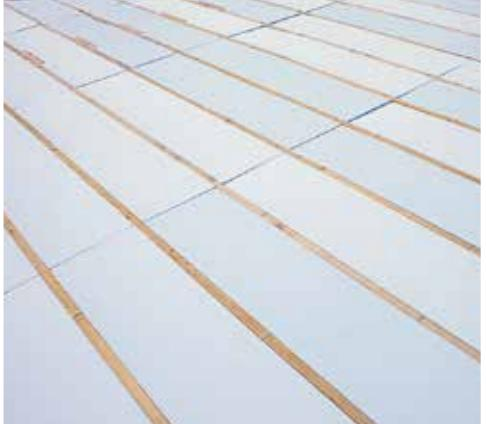
専用のWZピン™を用いて、根太間にスタイロフォーム™を隙間なく、はめ込む工法です。
