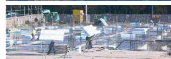
スタイロタック™は、フラットデッキ上の断熱施工の合理化・省力化を目的として開発された粘着剤付き**スタイロフォーム™**です。フラットデッキ上に敷き込むだけで固定され、両面テープや接着剤が不要、離型紙レスなのでゴミゼロ、ローコストを実現。ホットメルト系粘着剤は、点線状に塗布されているので、端材も全て使用できるので現場での材料ロスを最小限にとどめ、接着力も強く、雨にぬれても乾けば粘着性が復元する特別仕様ですので、気候、天候に左右されず使用することができます。
