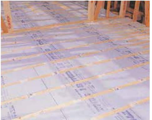
断熱材スタイロフォーム™を連結テープでセットアップ。広げればそのまま、根太を挟み込むようにして施工が完了する画期的な製品です。
