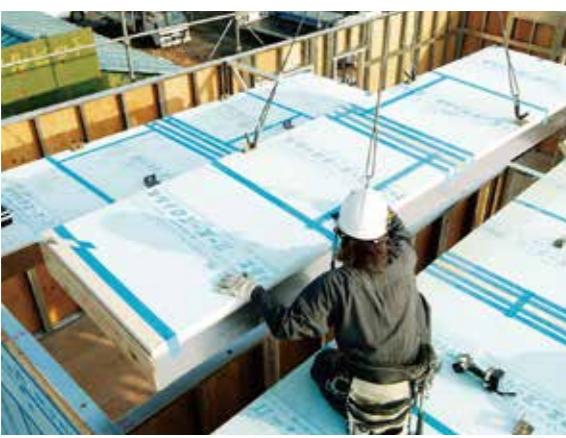
NSスーパーFRAME工法は、スチールの骨組みにスタイロフォーム™の外張断熱を採用した建築工法です。スチール(薄板軽量形鋼)と構造面材(構造用合板、パーティクルボード、石膏ボード、セラミック系面材など)を組み合わせた「壁パネル」「床パネル」で構成された、ハイブリッドなパネル工法で、防耐火・遮音・温熱性・耐久性や施工性にも優れています。
