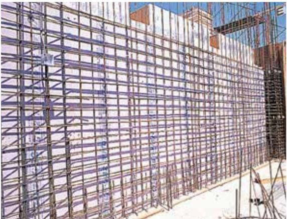
スタイロフォーム™をコンクリート躯体に施工する場合に、もっとも簡単で確実な工法です。コンクリート打込みの際は、きわめて大きな荷重が型枠面にかかりますが、**スタイロフォーム™**は、耐圧強度に優れているうえ、極めて高い耐水性を兼ねそなえています。
