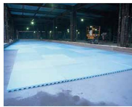
床断熱排水パネルによる湧水処理工法は従来の地中梁、耐圧盤等で構成される二重スラブ(湧水ピット)に代えて、必要な厚みと鉄筋量をもつ強化耐圧盤(マットスラブ)の上にドースイライナー™を敷き込み床仕上げコンクリートを打設し、低床湧水槽、断熱層を同時に形成する画期的な工法です。
