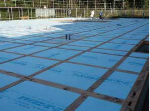
**ぴたっとカット**は、床組に根太を用いない大引間断熱に対応したシステムです。CADデータから断熱材の割付図面を作成し、加工場で断熱材を最適サイズにプレカットして納品します。そのため現場では、断熱材を受ける金具を大引に取付け、断熱材を落とし込むだけで済み、施工手間と端材の削減を両立します。
