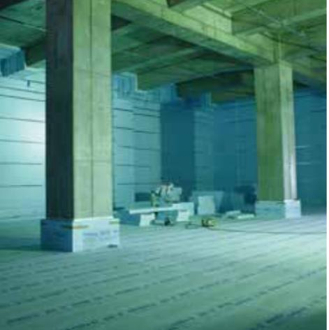
スタイルフォーム™を建物躯体の内側から取り付ける内防熱工法、従来より一般に施工されている工法で、鉄筋コンクリート造、鉄骨造いずれの建物にも施工可能です。また、建物をスタイルフォーム™で建物躯体の内外からすっぽり包み込む外防熱工法は、内防熱工法に比べ、冷熱橋ができにくく、同時に庫内空間を広く使えるという利点があります。ただし、外壁仕上げ材取り付けのためのボルトが冷熱橋になりやすいので注意を要します。
