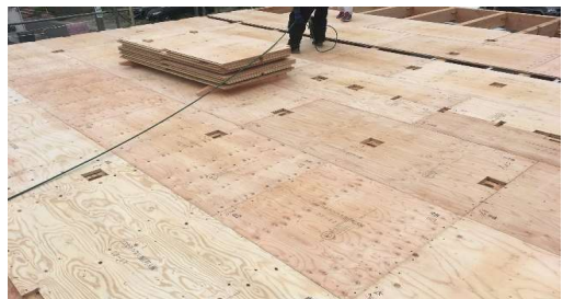
(図4:床断熱材はめ込み後の床合板敷き込み施工)
