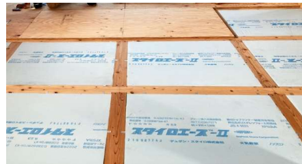
(図3:根太や大引きの間に断熱材のはめ込み)
