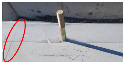
(図5:墨出し後の虫返し施工)
