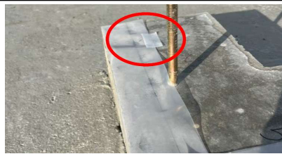
(図4:養生テープ貼り付け)
