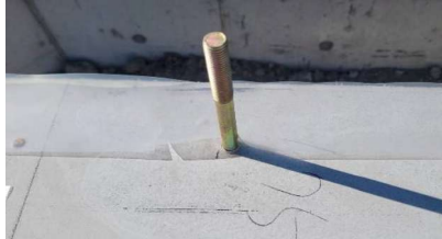
(図2:干渉部分の切り込み方法)
