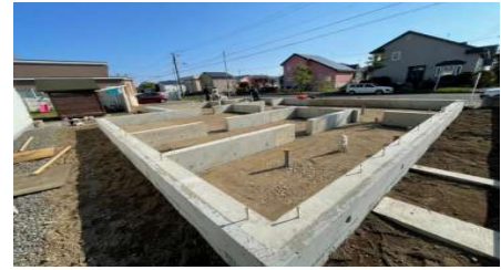
(図1: 碎石敷き込み・転圧後)
