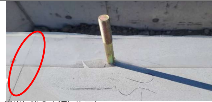
(図6:墨出し後の虫返し施工)
