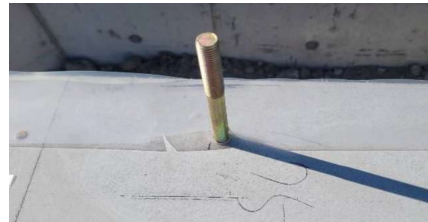
(図3: 干渉部分の切り込み方法)
