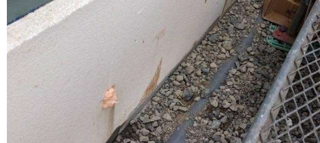
(図3:水抜き穴 テクノ防蟻フォーム施工)
