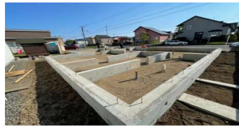
(図1: 碎石敷き込み・転圧後)
