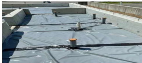
(図5: 配管貫通部処理方法)
