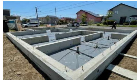
(図2: 防蟻防湿シート敷き込み後①)
