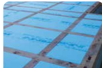
床断熱プレカット
