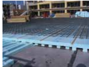
施工場所:東京都 部 位:公立中学校屋上 材 料:スタイロライナー™ 75~150mm
