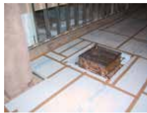
施工場所:埼玉県 部 位:ショッピングセンター店舗 材 料:スタイロライナー™ 100mm
