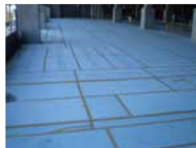
施工場所:埼玉県 部 位:ショッピングセンター店舗 材 料:イゲタライト™ 800mm
