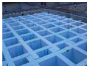
施工場所:埼玉県 部 位:私立大学体育館地下ピット 材 料:イゲタライト™ H=450mm
