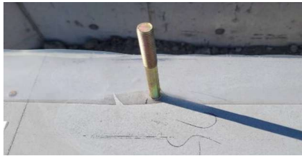
(図2: 干渉部分の切り込み方法)
