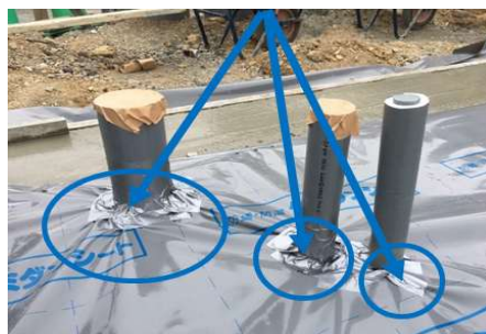
(図5:配管貫通部処理方法)
