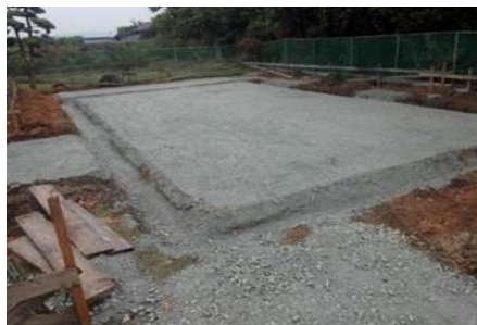
(図1:碎石敷き込み・転圧後)
