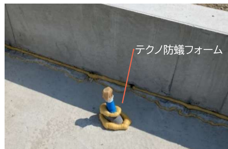
(図 2: 基礎貫通スリーブ テクノ防蟻フォーム施工)
