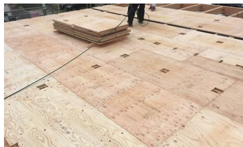
(図 5: 床断熱材はめ込み後の床合板敷き込み施工)
