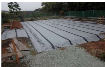
(図2:防蟻防湿シート施工)
