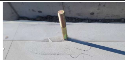
(図5:墨出し後の虫返し施工)
