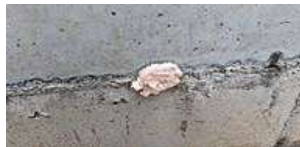
(図 3: 水抜き穴 テクノ防蟻フォーム施工)
