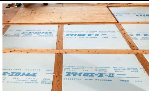
(図 4: 根太や大引きの間に断熱材のはめ込み)
