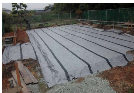
(図4:防蟻防湿シート敷き込み場所)
