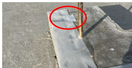
(図4:養生テープ貼り付け)
