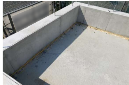
(図 1: 基礎外周全周 テクノ防蟻フォーム施工)
