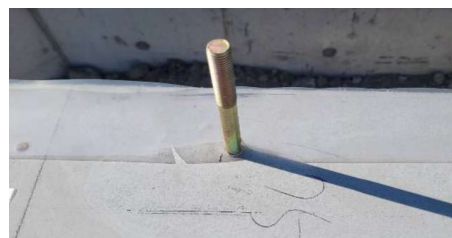
(図2:干渉部分の切り込み方法)
