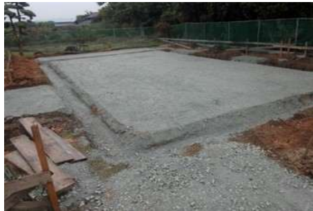
(図1: 砕石敷き込み・転圧後)
