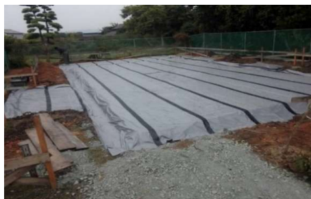
(図2: 防蟻防湿シート施工)
