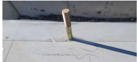
(図5:墨出し後の虫返し施工)
