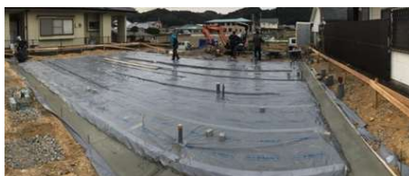
(図6:捨てコン施工後の防蟻防湿シート写真)
