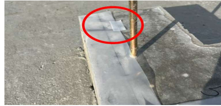
(図4:養生テープ貼り付け)
