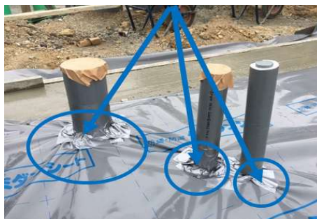
(図5:配管貫通部処理方法)
