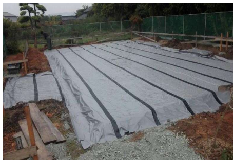
(図4: 防蟻防湿シート敷き込み場所)
