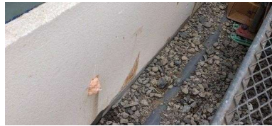
(図 4:水抜き穴 テクノ防蟻フォーム施工)
