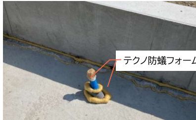
(図 3:基礎貫通スリーブ テクノ防蟻フォーム施工)
