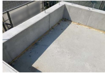
(図 2:基礎外周全周 テクノ防蟻フォーム施工)
